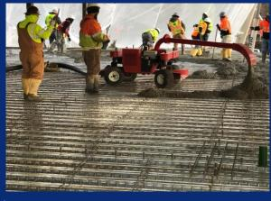
2<sup>nd</sup> level west elevated slab pour in progress
